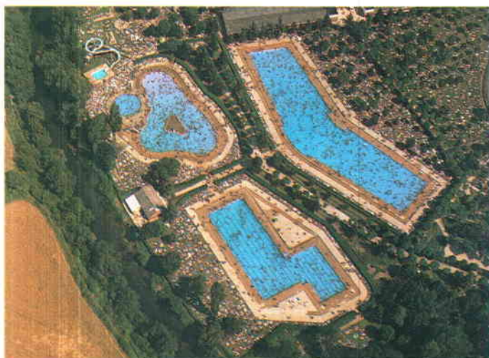
Vista aérea de una parte del complejo polideportivo Gamarra.
